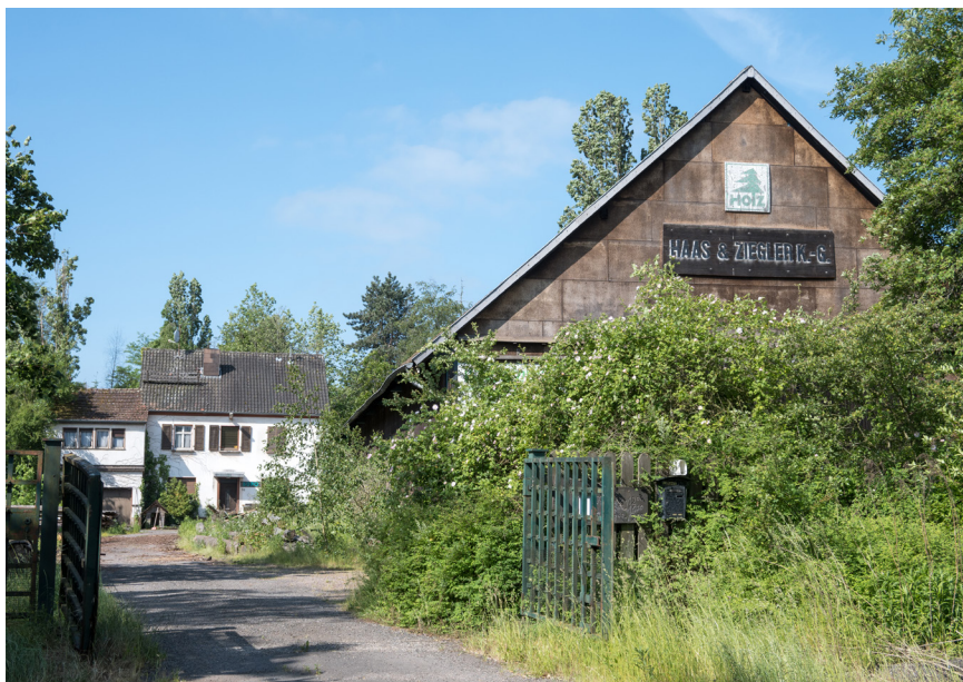
Blick ins Plangebiet aus Richtung Osten
