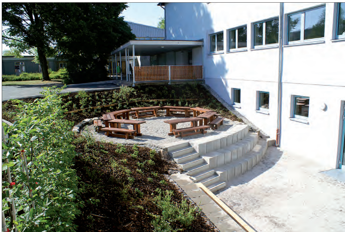
Grünes Klassenzimmer an der Grundschule Wellesweiler
