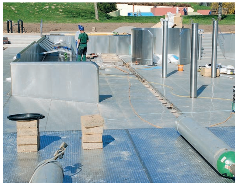
Die Arbeiten laufen auf Hochtouren (hier im April 2011). Foto: HuwerLogo
