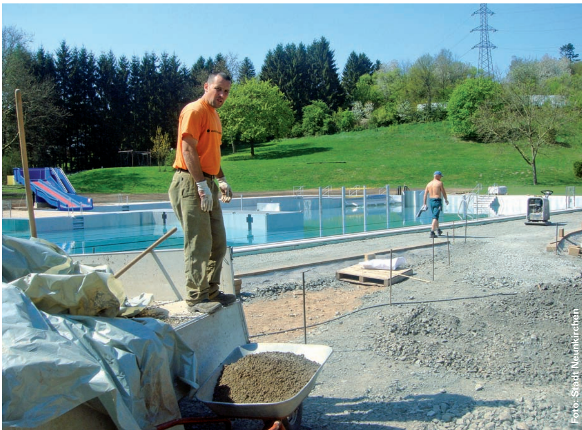
Nun wird der Belag rund um das Wiebelskircher Becken verlegt.
