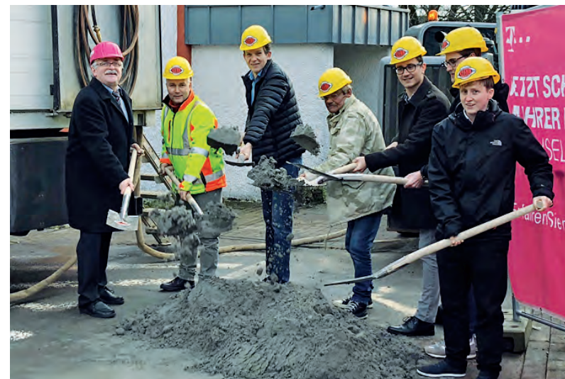
Spatenstich mit Bürgermeister Aumann für Glasfaserausbau Foto: Telekom
