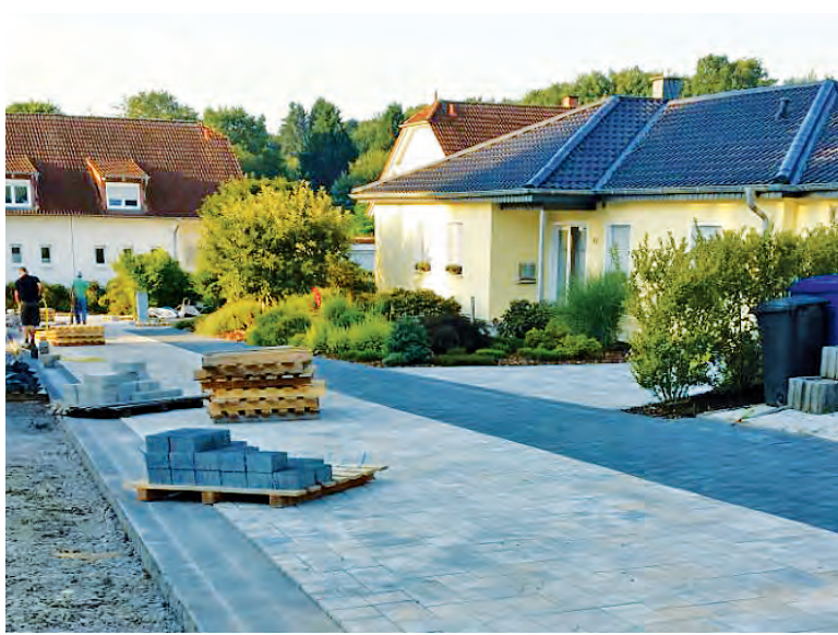
Der Täufergarten wird gepflastert.
