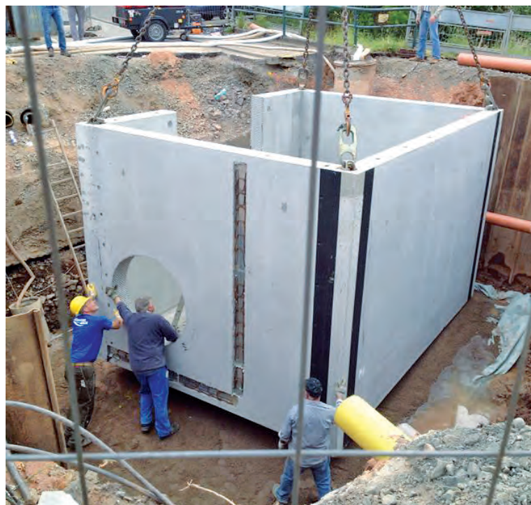
Ein riesiges Kanalbauwerk wird eingesetzt. Foto: Stadt Neunkirchen
