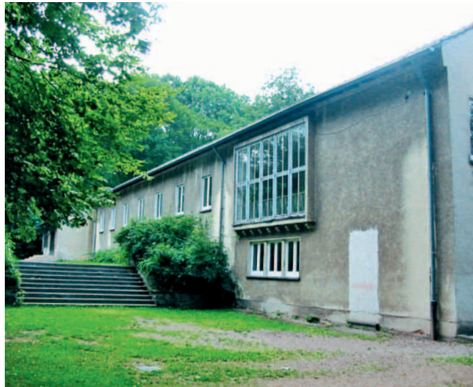
Grundschule Heinitz: ein Gebäudeteil wird abgerissen.
