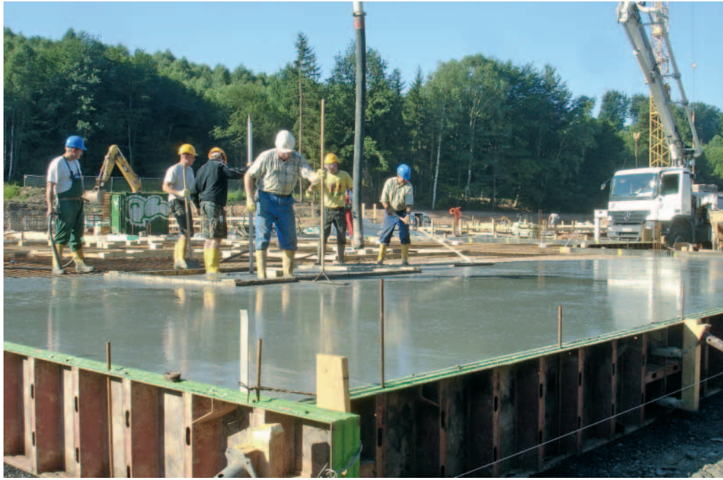
Letzte Woche wurde die Bodenplatte für die Sauna betoniert, diese Woche folgt der Umkleidebereich. Fleißige Bauarbeiter haben die Verspätung im Zeitplan aufgeholt.
