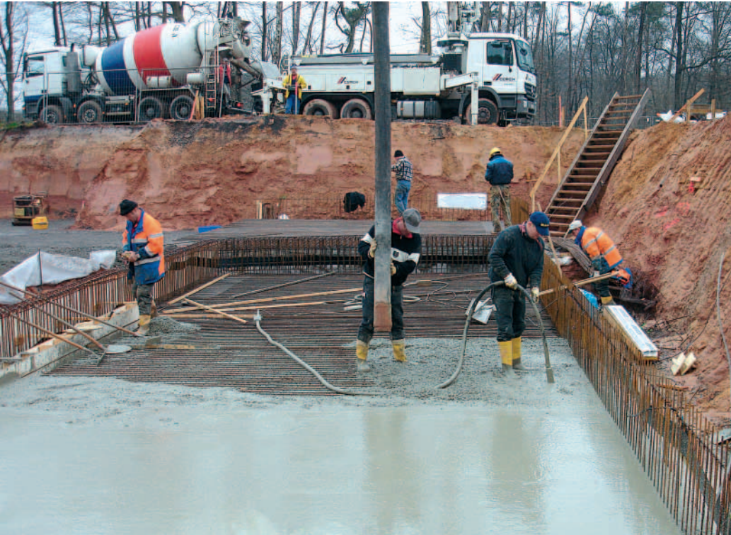
Ganzer Einsatz für das neue Kombibad in der Lakaienschäferlei
