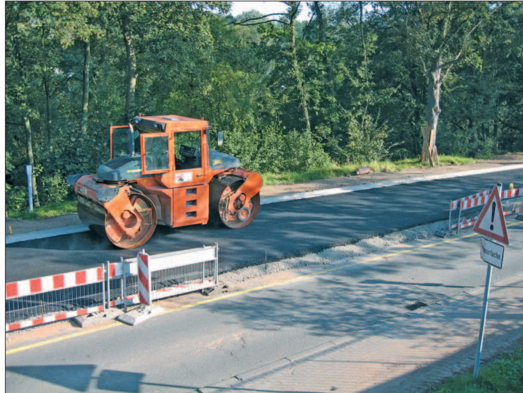
Stadtmomente: Eine Seite der Bliesstraße ist fertig.
