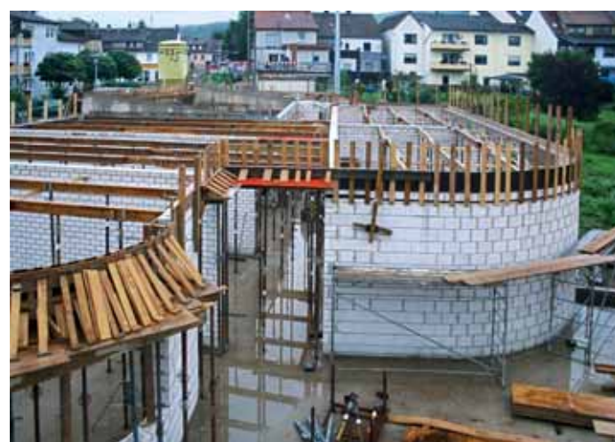
Die Arbeiten an der Schillerschule gehen voran.
