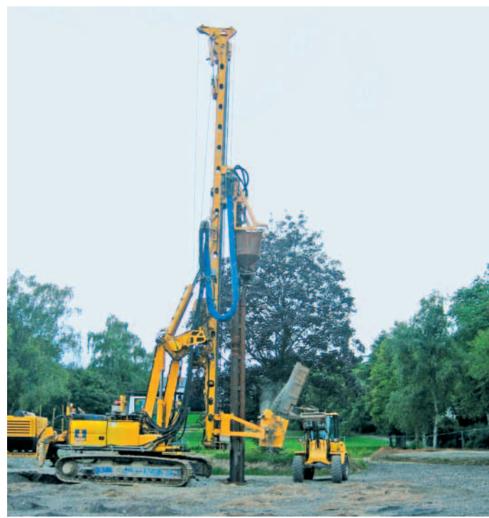
Arbeiten um Kiga Ringstraße laufen auf Hochtouren.
