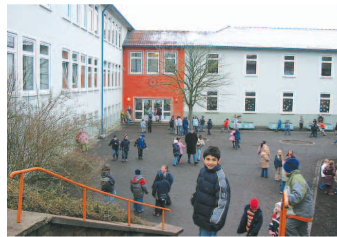
Ehemalige Scheibschule: Künftig werden hier Erzieherinnen ausgebildet.
