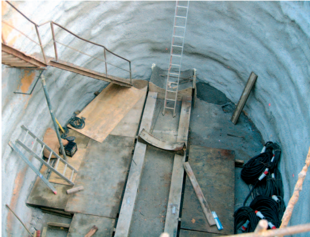
Riesige Baugrube: Kanalbaumaßnahme im Winterfloß
