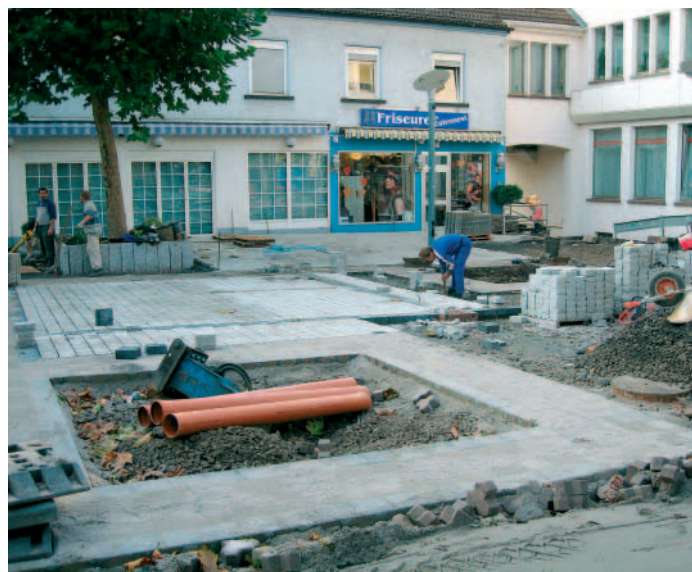
Pflasterarbeiten im Hammergraben
