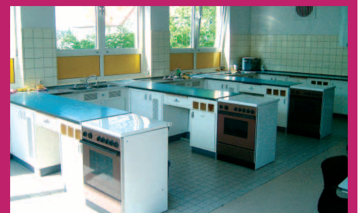
Küche der Grundschule Furpach
