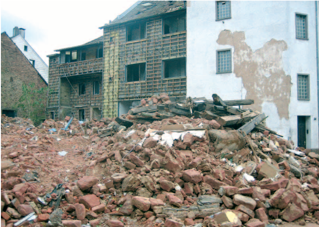
Ortsmitte Wellesweiler: Erst kommt der Abriss, dann der Umbau
