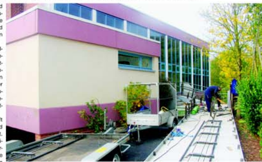
Die letzten Arbeiten laufen für eine behindertengerechte ausgebaut Ostertalhalle.
