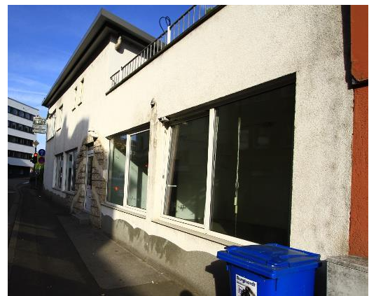
Denkbare Verortung: Leer stehendes Gewerbeobjekt in der Wellesweilerstraße (Foto: agstaUMWELT)
