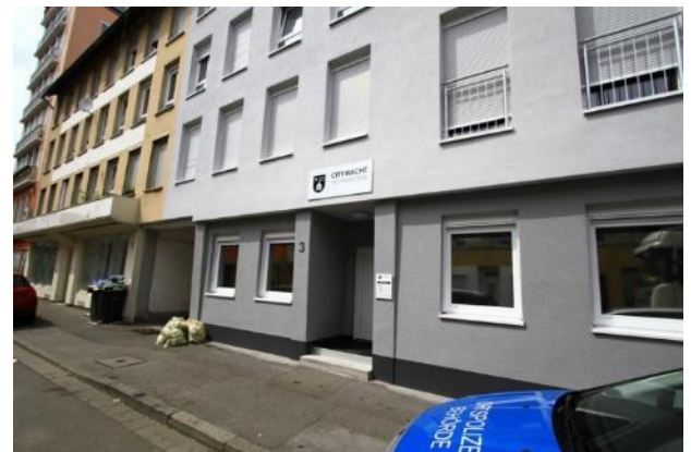
Saniertes Gebäude der GSG in der Wellesweilerstraße 3 Foto: agstaUMWELT
