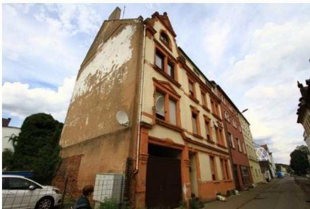
weitgehend leer stehendes Gebäude in der Goethestraße 7
