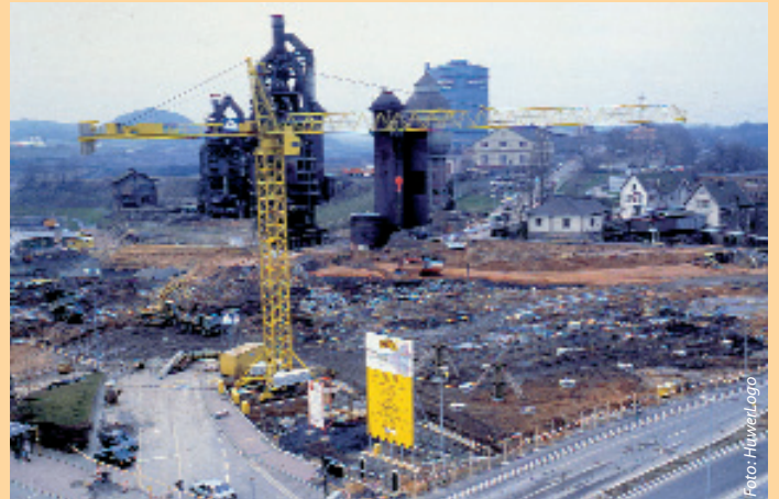
Der Umbau hat begonnen
